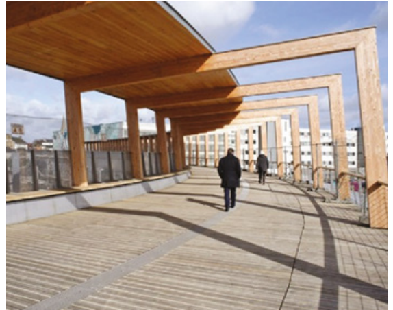
Beispiel grosszügige Bahnhofbrücke (Bahnhof Saint Laud (F))
