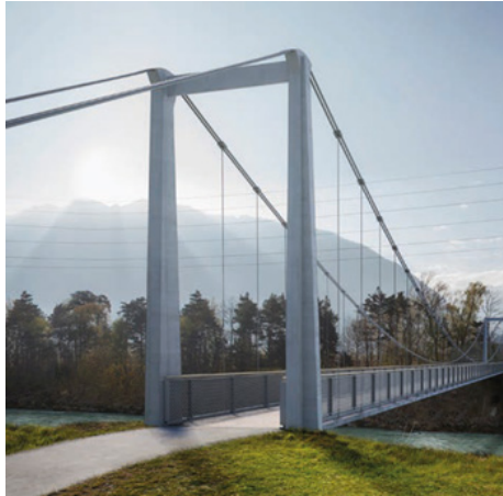
Beispiel Rheinbrücke zwischen Chur und Haldenstein (Quelle: suedostschweiz)
